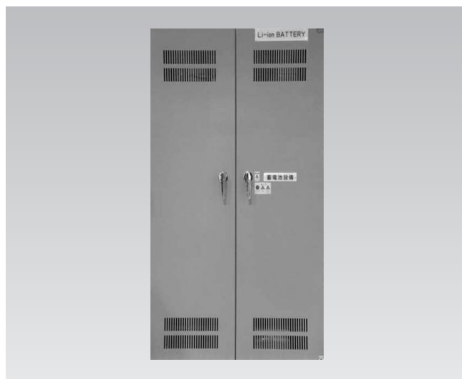
図3 リチウムイオン蓄電池盤外観写真
