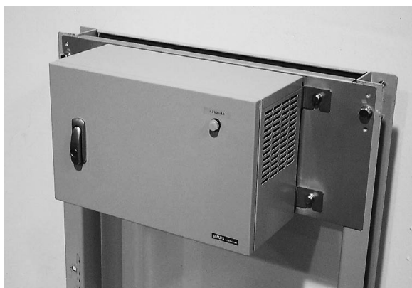
図5 1.5kVAトランス盤の外観
