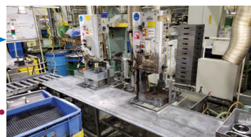
生産終了後、設備へのエア供給を自動停止
