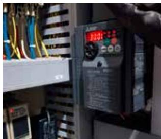
インバータによるポンプの最適制御
