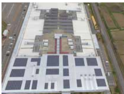
神川工場屋上 太陽光発電システム増設後
