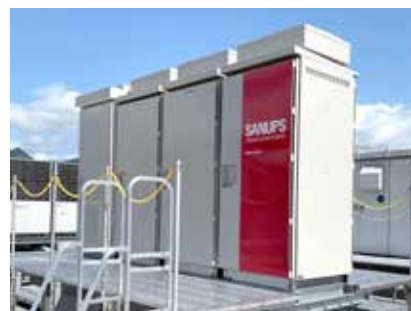
神川工場 太陽光発電用パワーコンディショナー
