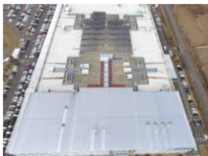
神川工場屋上 太陽光発電システム増設前
