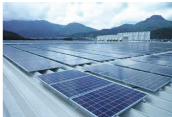
ロジスティックセンターの太陽光パネル
