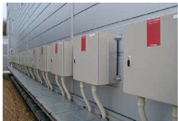
富士山工場の太陽光発電用パワーコンディショナ
