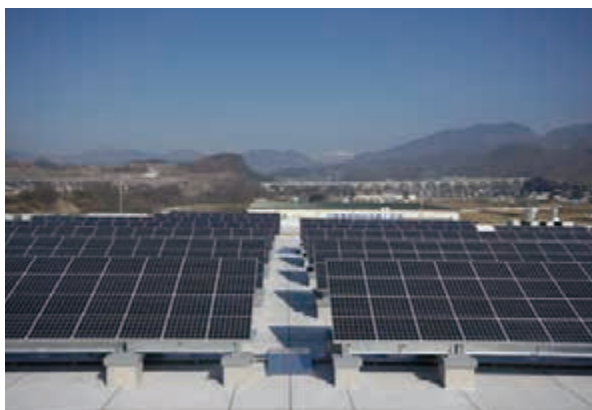
神川工場の太陽光パネル
