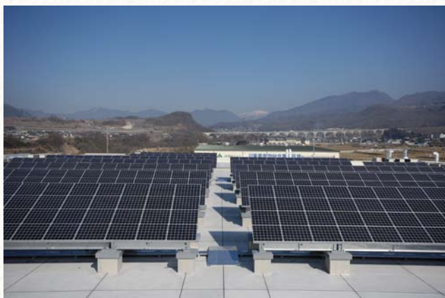
神川工場の太陽光パネル
