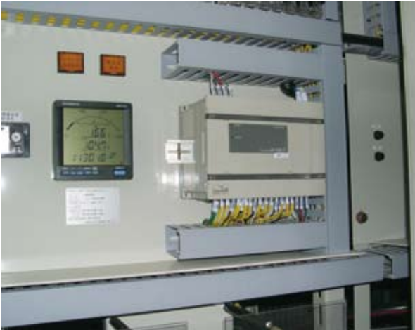
エネルギー計測システム
