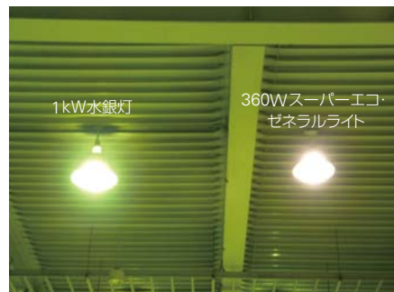
水銀灯の点灯比較
